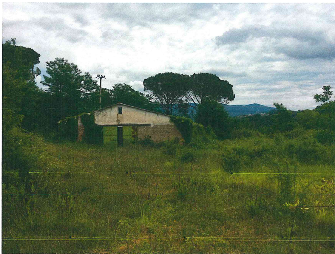
Foto n. 4 - stalla e terreno Comune di Forano fg. 16 mapp. 217-266 – soc. Agricola Paraelios srl
